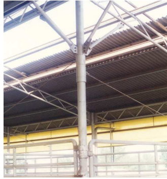
기둥 및 경첩 설치공사
