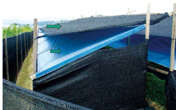
<고온기 추가 2중직 차광망 설치>
